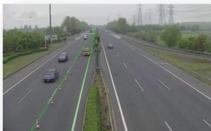
路上事件及施工安全检测
